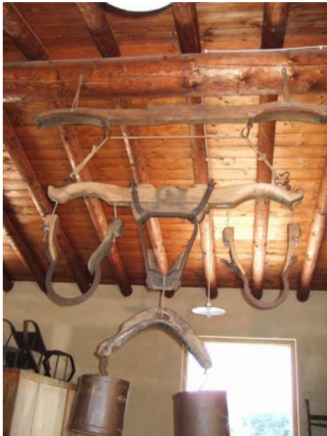
Il soffitto della stalla
