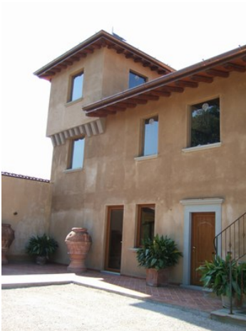
L'edificio rifinito in Pietra di Sarnico
